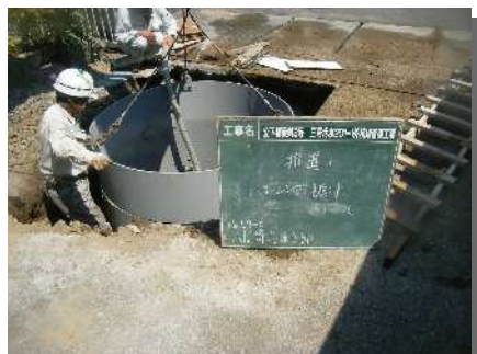
中間ケーシング 建込状況
