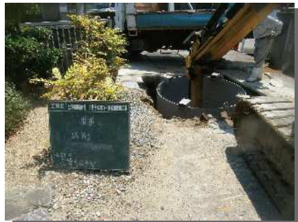
先端ケーシング内 掘削状況
