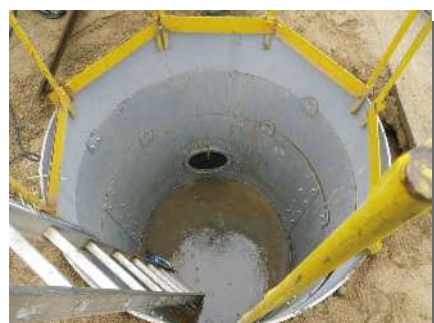
ケーシング 建込完了
